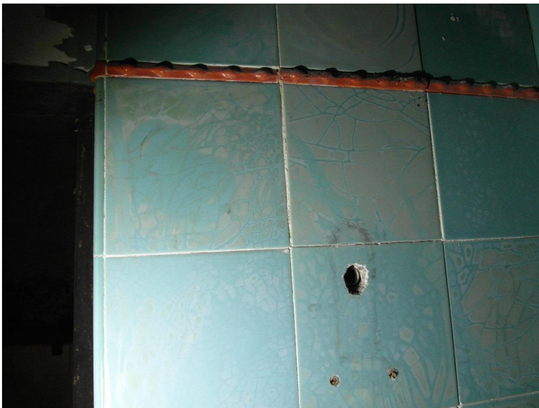
Fot. Nr 53. Widoczne liczne pęknięcia. Wilgoć dostająca się od spodu doprowadziła do miejscowych zmian koloru.
