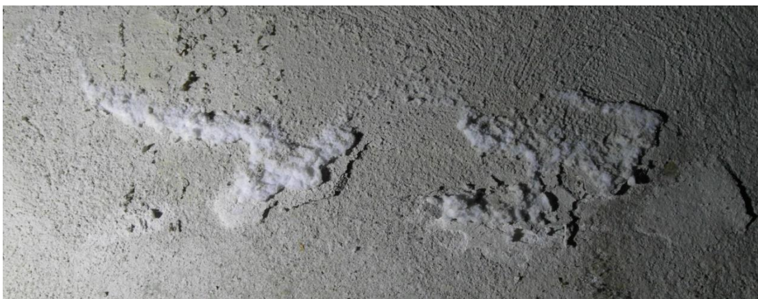
Fot. Nr 44. Widać wykwyty solne i łuszczące się partie zawilgoconych tynków
