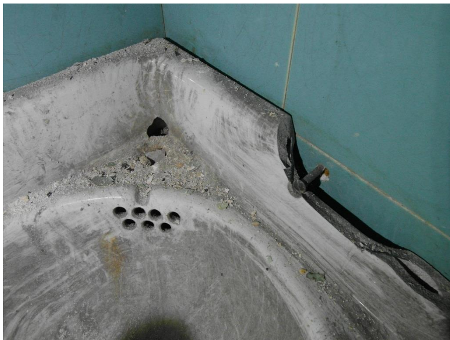
Fot.nr 55. Ceramika bardzo zabrudzona, uszkodzona, miejscowo zmieniona kolorystyka.
