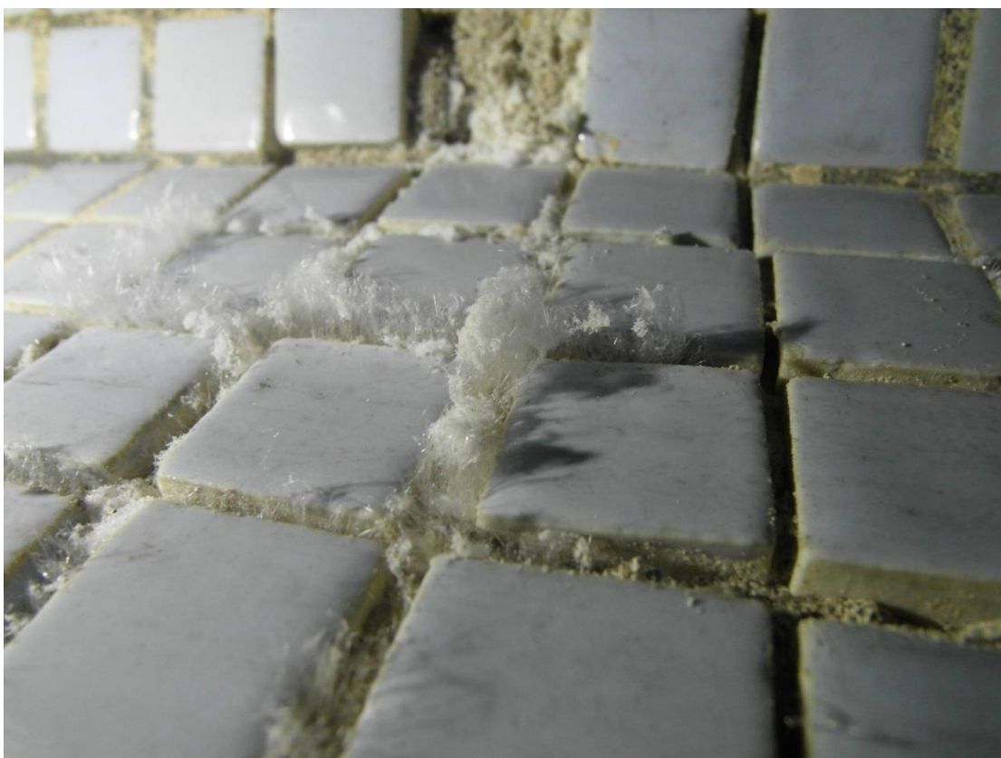
Fot. Nr 112. Widok makro. Widoczna spoina łącząca płytki mozaiki na ścianie. Biała plama w środku- skryształizowana sól, cała spoina mocno pociemniała zaatakowana przez grzyby.
