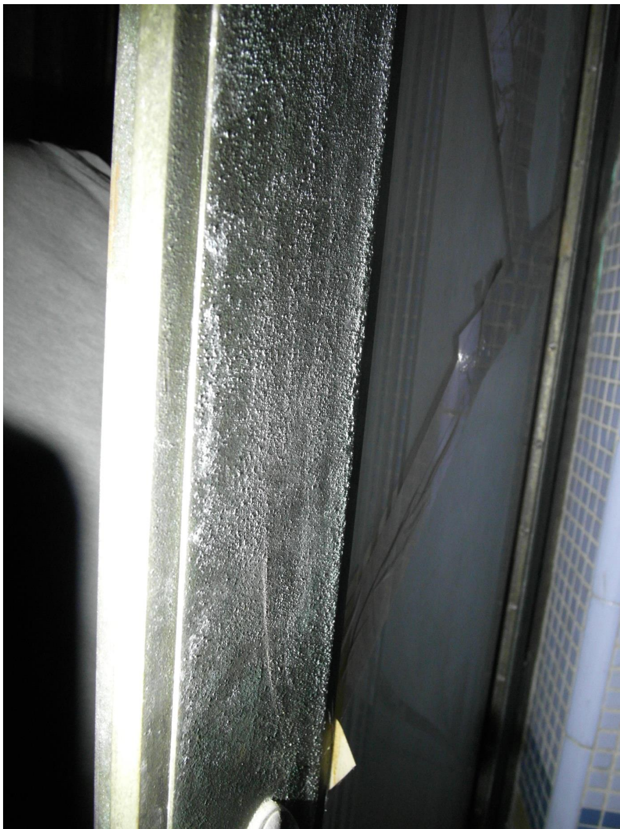
Fot. Nr 116. Mocno spatynowane drzwi metalowe do pomieszczenia nr 40 w świetle bocznym, widoczne skryształizowane wykwity będące efektem postępującej degradacji związanej ze zbyt wysoką wilgotnością ścian.
