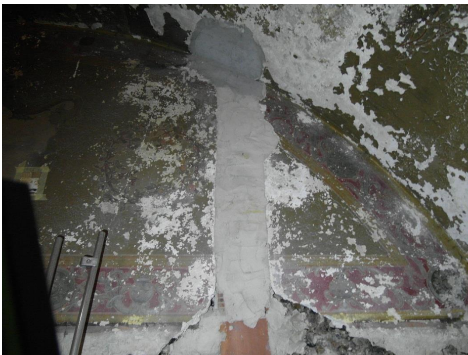
Fot. Nr 83,84. Współcześnie wykonane przekucia do instalacji elektrycznej i co uzupełnione zaprawą tynkarską i cementową. Poważnie uszkodziły polichromie i tynki a także powiększyły odspojenia.
