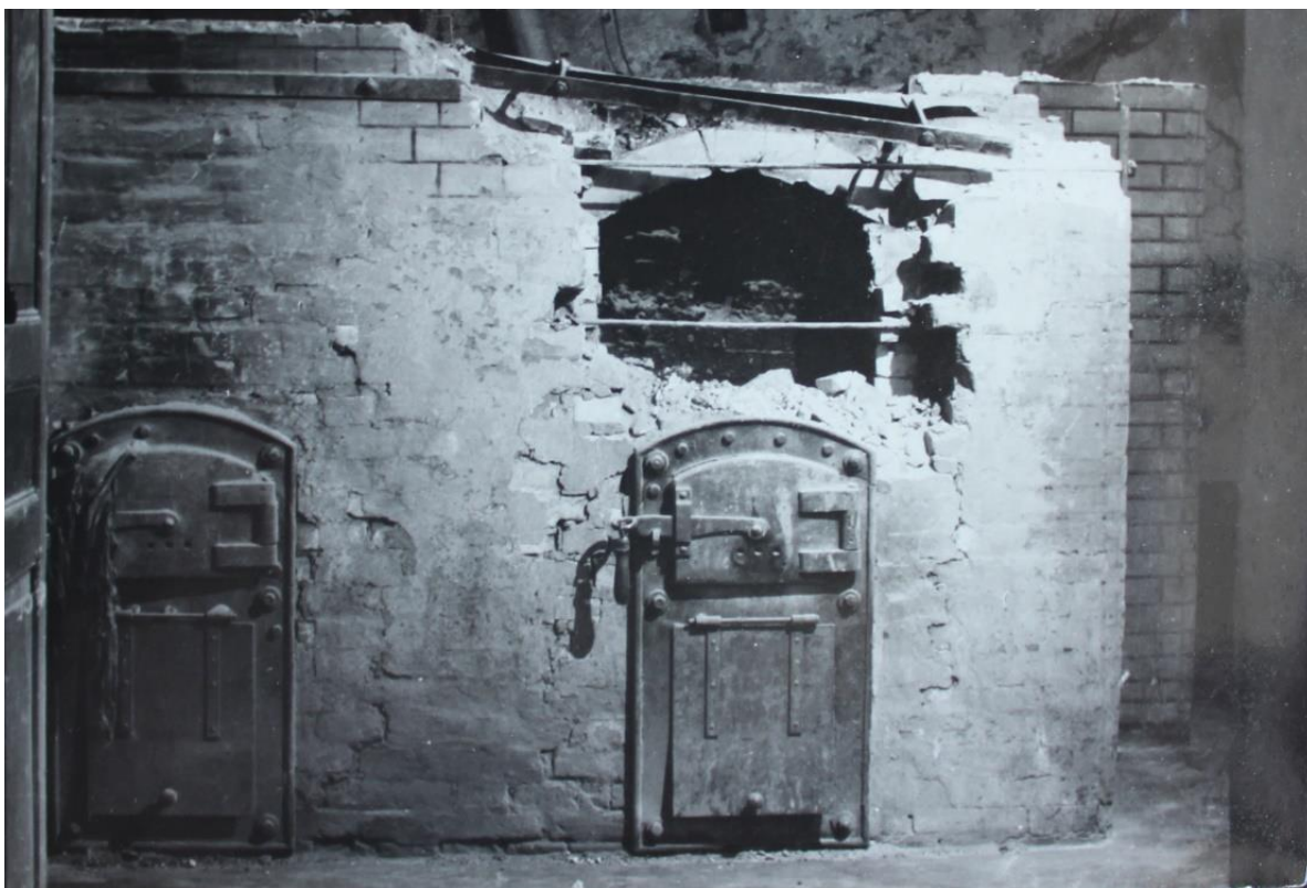
Il. 1. Stary piec centralnego ogrzewania przed rozbiórką, 1959 r., źródło: Archiwum Muzeum-Zamku w Łańcucie.
