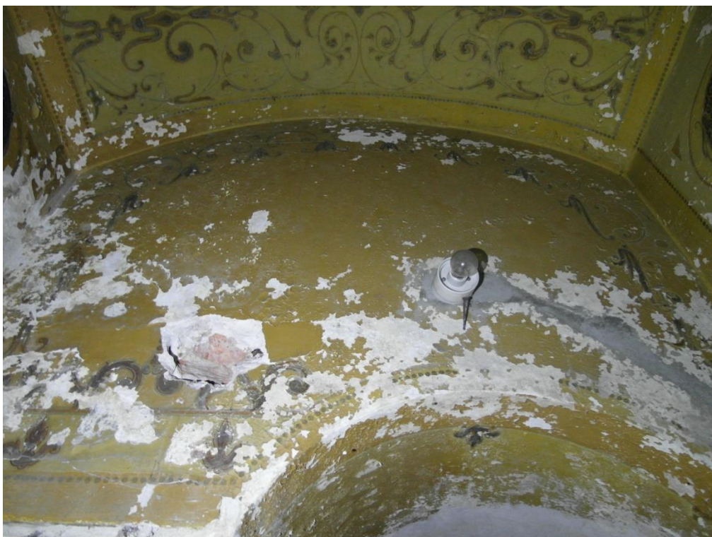
Fot.nr 59. Widoczne zniszczenia: Warstwa malarska mocno zabrudzona, przemalowana, łuszcząca się, po lewej ubytek mechaniczny do wątku ceglanego, z prawej współczesne przekucie elektryki wadliwie uzupełnione zaprawa cementową. Stan warstwy malarskiej jest tak zły, że jakiegokolwiek przypadkowe dotknięcie powoduje jej ubytek.
