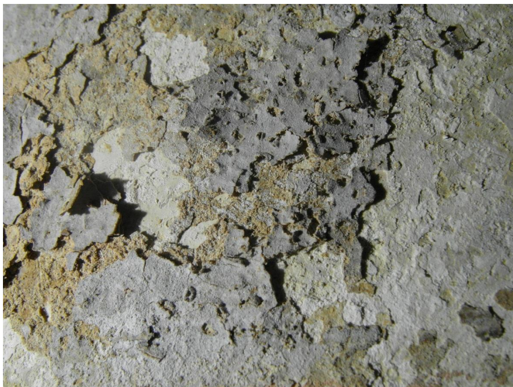
Fot. Nr 82. Fragment całkowicie zdegradowanej warstwy malarskiej.
