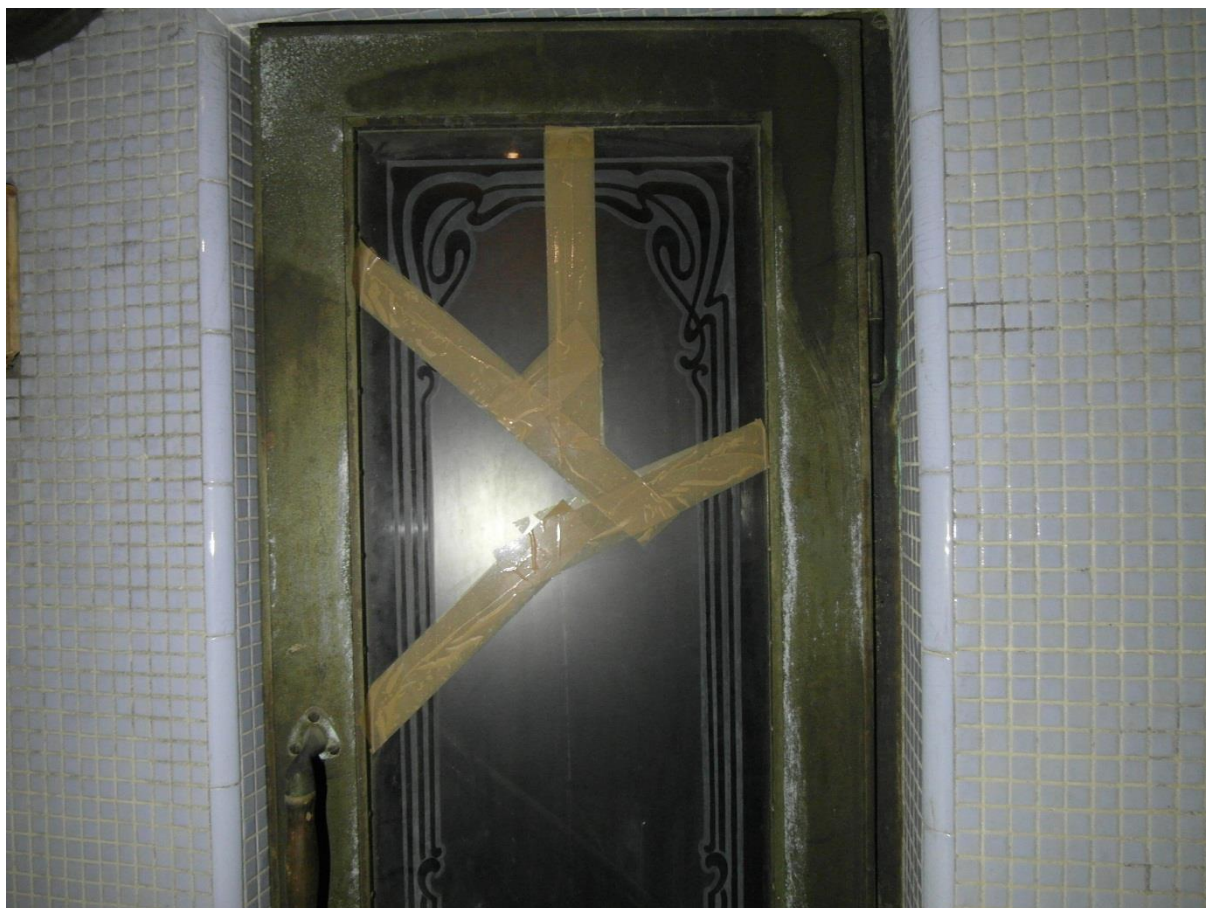
Fot. Nr 115. Drzwi do pomieszczenia nr 40. Widoczna spękana szyba zabezpieczona taśmą i rozległa korozja metalowych elementów drzwi.
