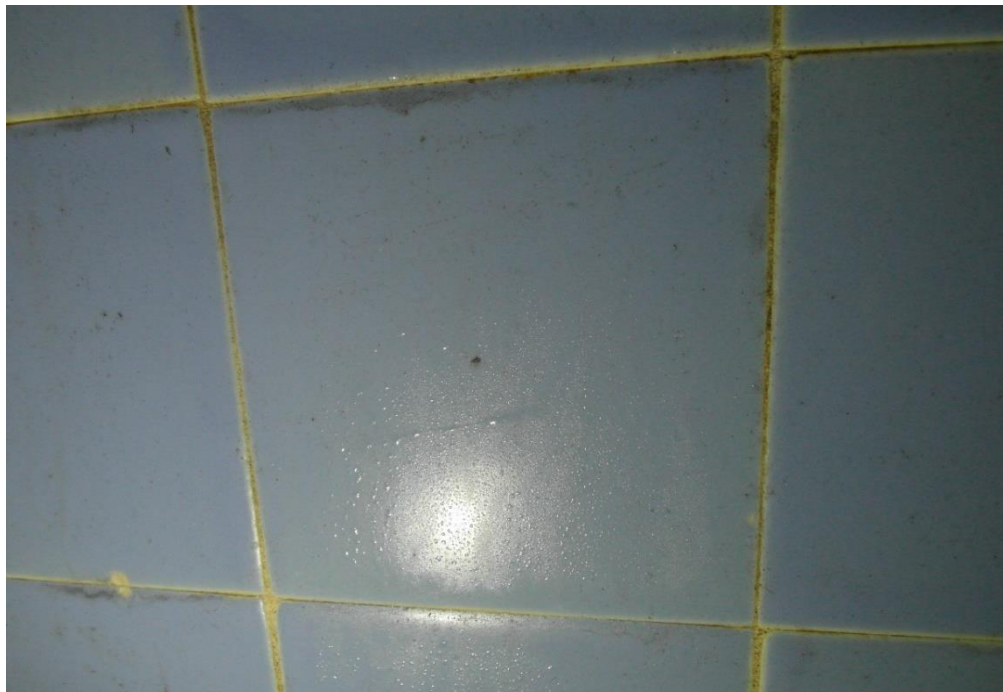
Fot. Nr 126. Widoczna skraplająca się woda na płytkach i zaatakowane przez grzyby spoiny.
