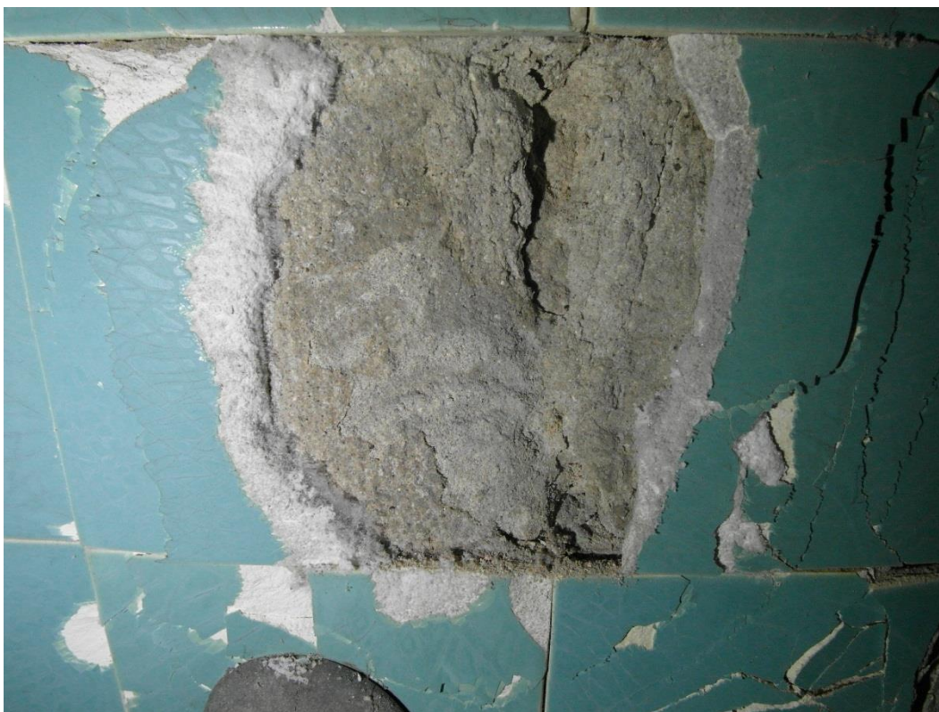
Fot. Nr 52. Widoczny duży ubytek spowodowany silnym zawilgoceniem ściany. Wokół ubytku krystalizują sole. Obok kolejne popękane fragmenty płytek powoli odrywają się od ściany.
