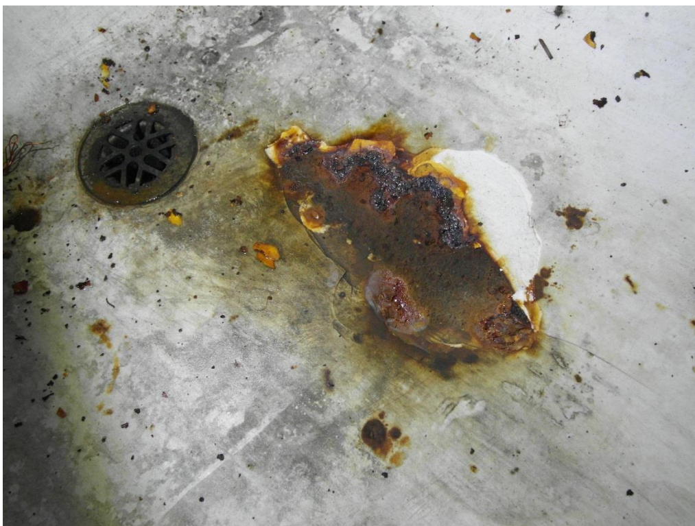
Fot. Nr 118. W dużym ubytku ceramiki widoczny korodujący metal.
