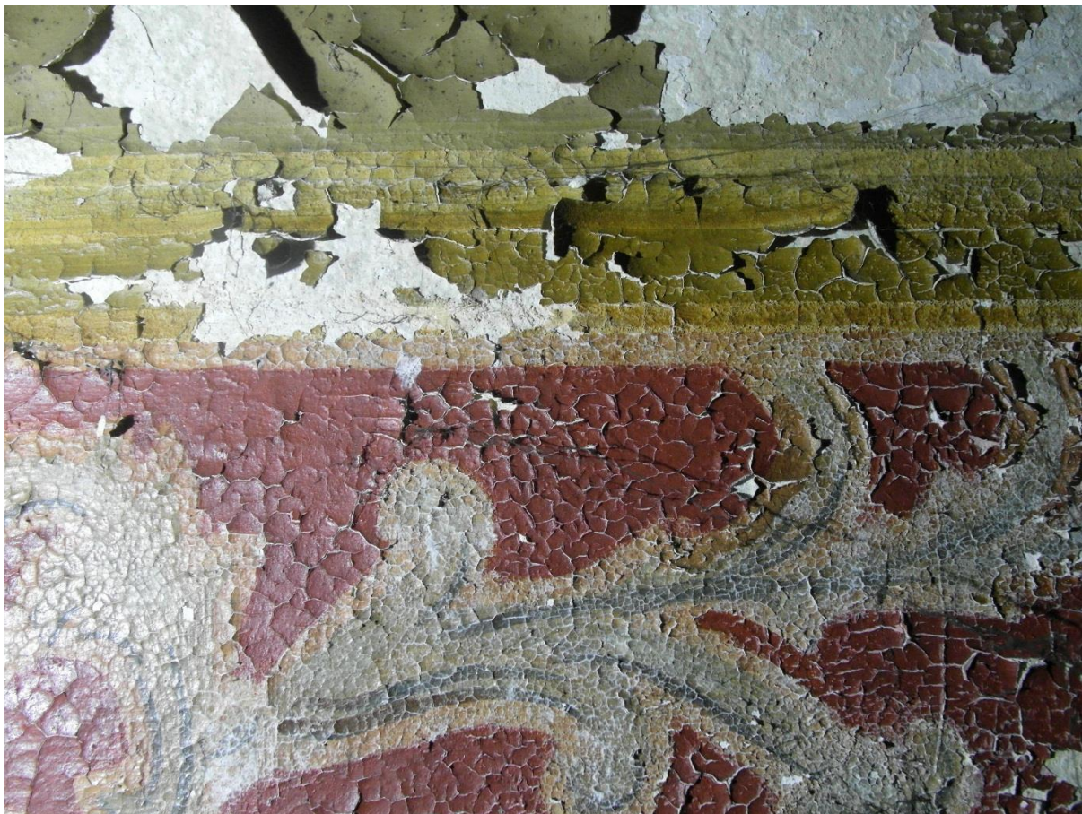
Fot. Nr 80. Widoczne łuskowate odspojenia. Warstwa malarska pęka, skręca się, łuszczy i całkowicie odspaja od podłoża.
