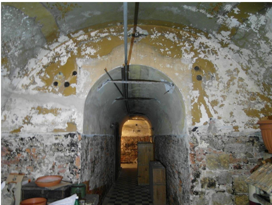
Fot. Nr. 68. Widoczne ciągle postępujące zniszczenia warstwy malarskiej. Pas odsłoniętego wątku muru określa wysokość boazerii. Nad łukiem korytarza widoczny jaśniejszy ślad po boazerii.
