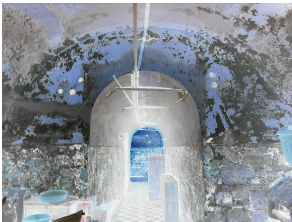
Fot. Nr. 68. Widoczne ciągle postępujące zniszczenia warstwy malarskiej. Pas odsłoniętego wątku muru określa wysokość boazerii. Nad łukiem korytarza widoczny jaśniejszy ślad po boazerii.
