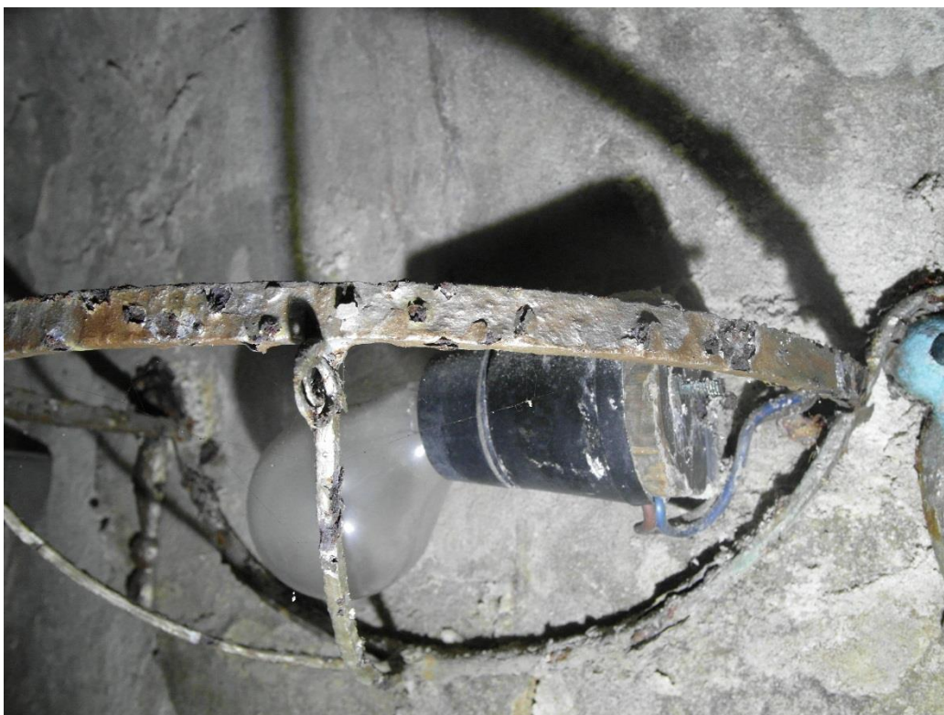
Fot. Nr 49. Widoczne ogniska rdzy na metalowej strukturze. Brak klosza, elektryka sprawna.
