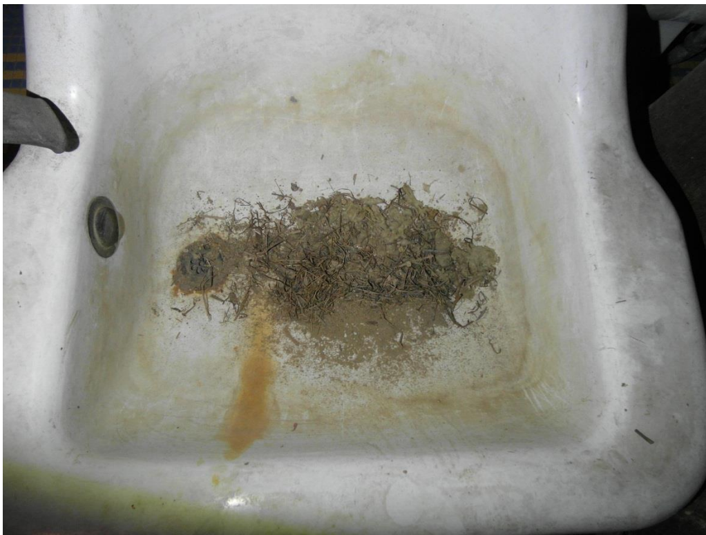
Fot.nr 119. Ceramika mocno zabrudzona, matowa. Widoczna duża rdzawa plama. Armatura brudna, mocno spátynowana.
