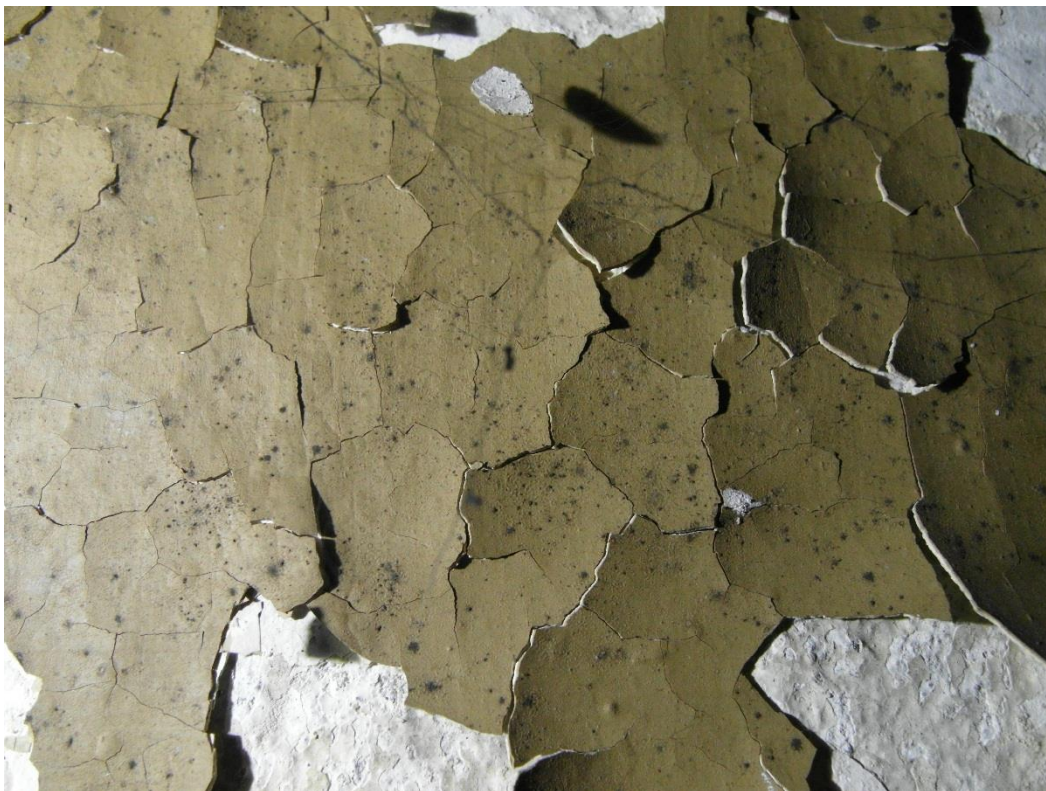
Fot. Nr 80. Widoczne łuskowate odspojenia. Warstwa malarska pęka, skręca się, łuszczy i całkowicie odspaja od podłoża.
