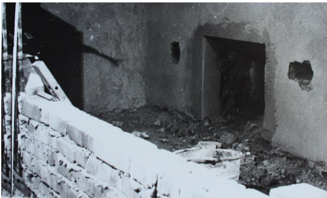
Il. 6. Piwnica pod wieżą pn.-zach., podmurowanie fundamentów, czerwiec 1960 r., źródło: Archiwum Muzeum-Zamku w Łańcutie.
