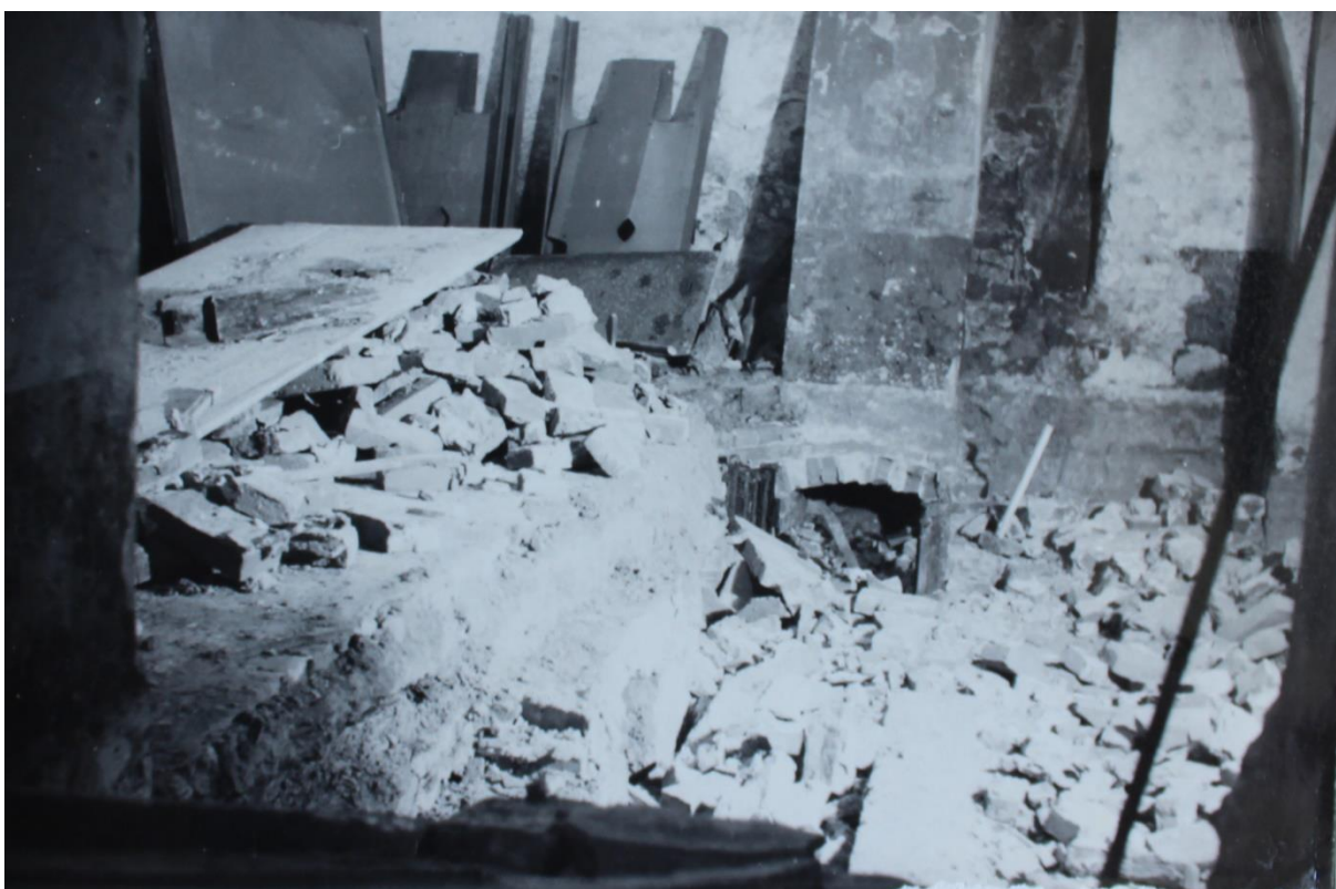
Il. 2. Wykop pod nowy piec centralnego ogrzewania, sierpień 1958 r., źródło: Archiwum Muzeum-Zamku w Łańcucie.
