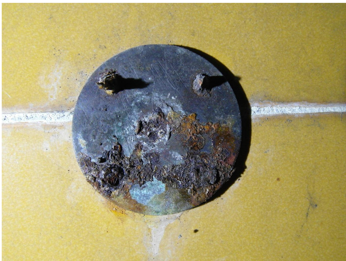
Fot. Nr 133. Elementy metalowe brudne, niekompletne, zaśniedziałe, częściowo skorodowane z widocznymi ogniskami rdzy.
